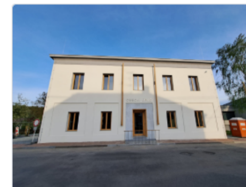
Budova obecního úřadu Václavovice Rekonstruovaný objekt
