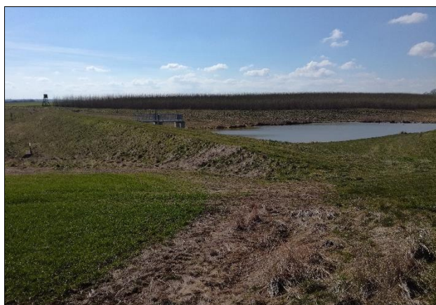
Suchá hráz (nádrž Bravantice) slouží k zadržení srážkových vod z okolního svažitého terénu
