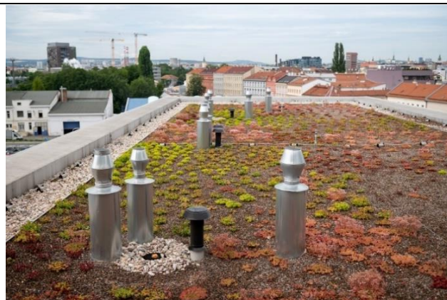
Zelená střecha v Brně na ul. Svatopeterská
