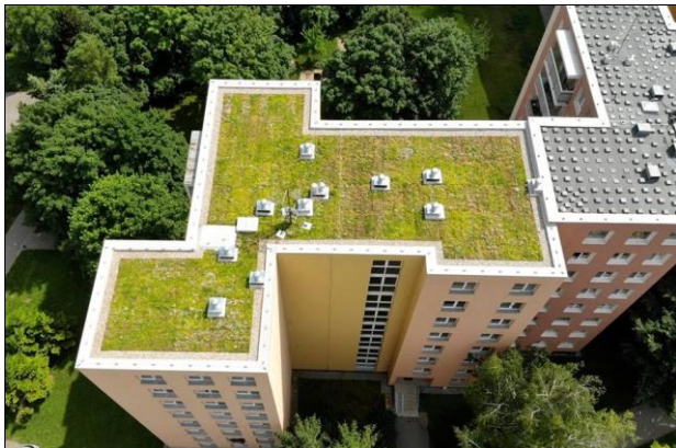
Zelená střecha bytového domu v Brně Bohunicích
