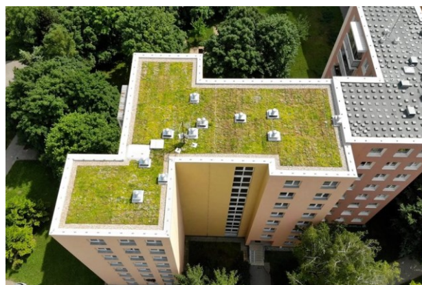
Obr. 47: Zelená střecha bytového domu v Brně Bohunicích
